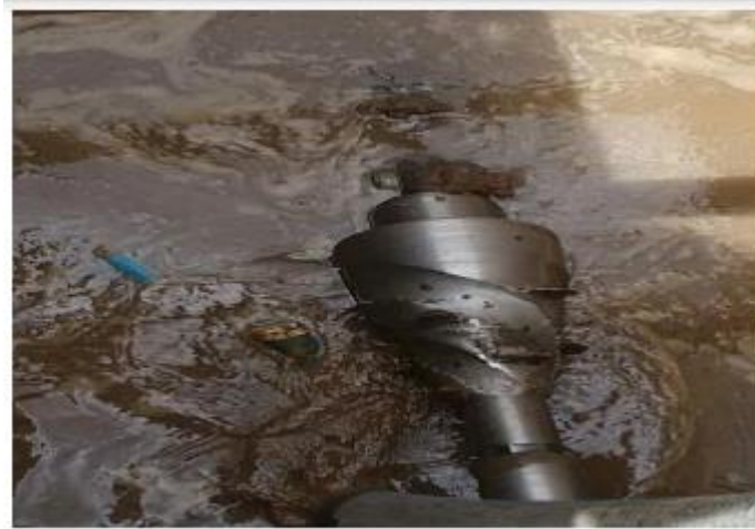
Figura 3 – Alargador de furo utilizado de forma conjunta ao puxamento da tubulação, em Criciúma/SC (Fonte: Coral e Steiner, 2015).
