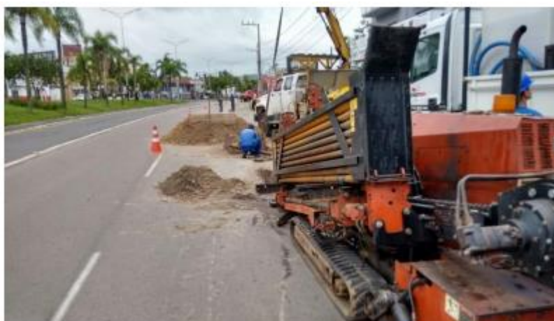
Figura 2 – Equipamento utilizado para perfuração, em Criciúma/SC (Fonte: Coral e Steiner, 2015).
