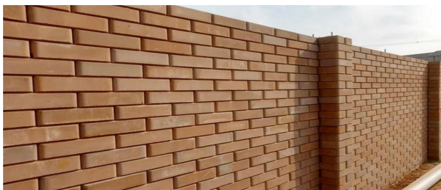
Figura 8 – Construção de tijolo ecológico. Fonte: Miranda (2019)
