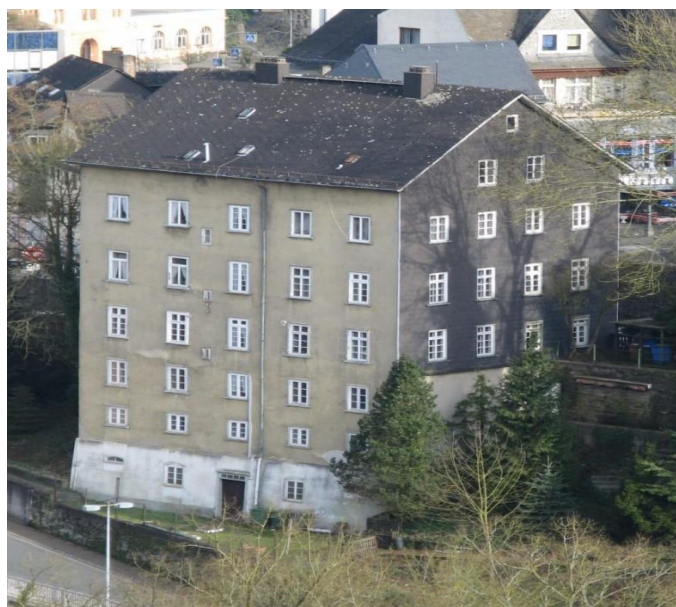
Figura 3 – Edifício de barro em Weilburg, Alemanha. Fonte: NTC Brasil (2015)
