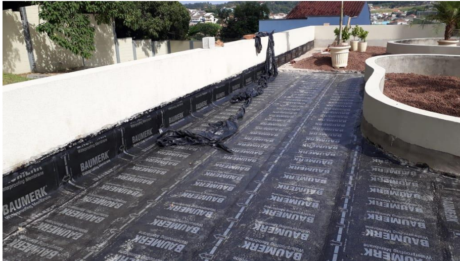
Figura 8: Aplicação da manta asfáltica Fonte: Autoria própria, 2020
