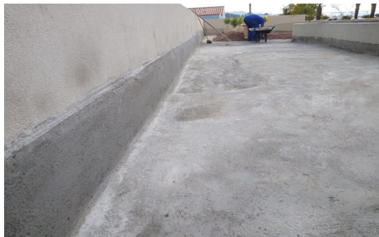
Figura 9: Proteção mecânica e reboco na mureta Fonte: Autoria própria, 2020
