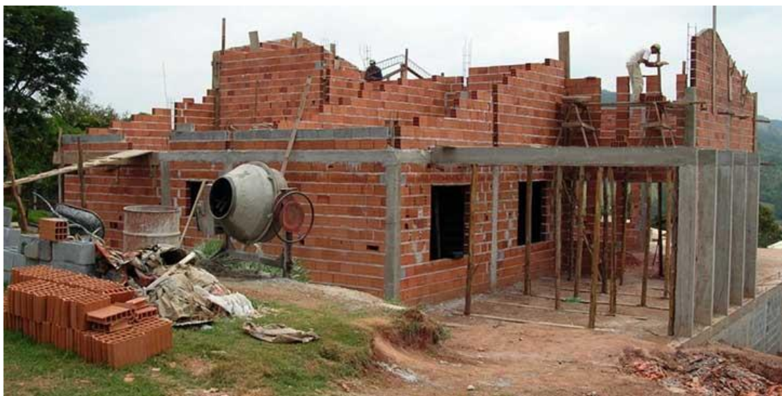
Figura 1 - Construção de Alvenaria convencional em execução (Fonte: http://www.forumdaconstrucao.com.br/conteudo.php?a=8&Cod=2041 )
