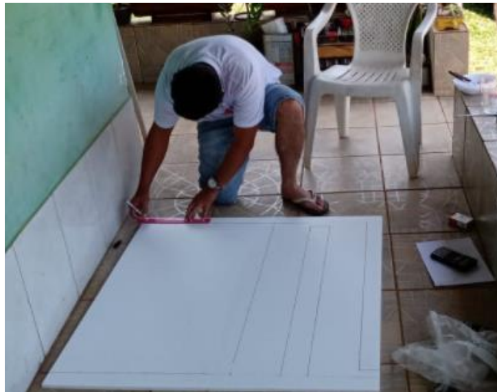
Figura 10 - Marcações nas chapas de EPS (Fonte: Autor).
