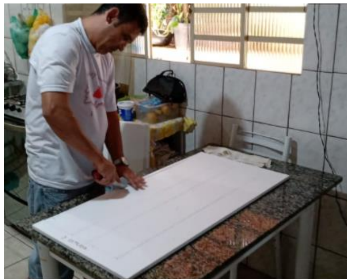
Figura 11 - Recortes nas chapas de EPS (Fonte: Autor).
