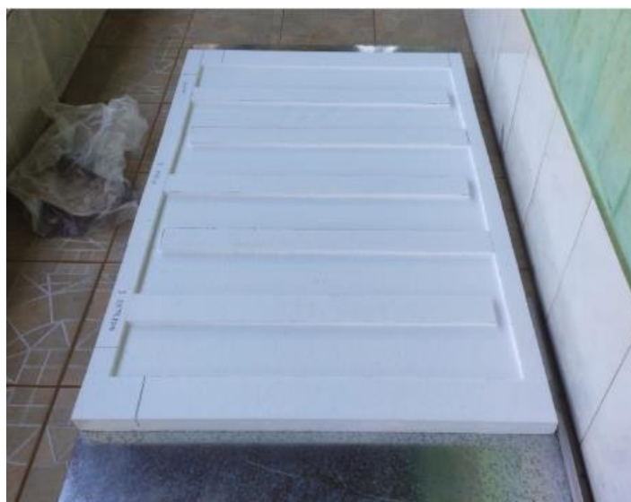
Figura 12 - Chapas de EPS coladas (Fonte: Autor).
